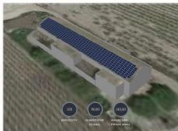
100 kWc installés à l'ouest
